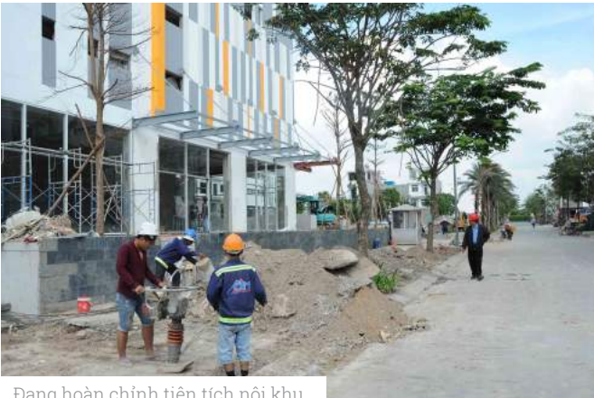
Đang hoàn chỉnh tiện tích nội khu
